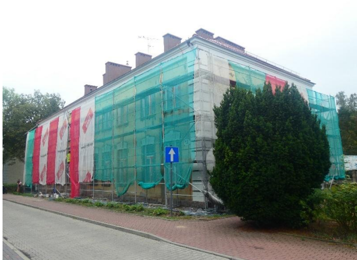
Fot. 3. Trwające prace remontowe przy elewacji budynku przy ul. Osiedle Wojskowe 13
