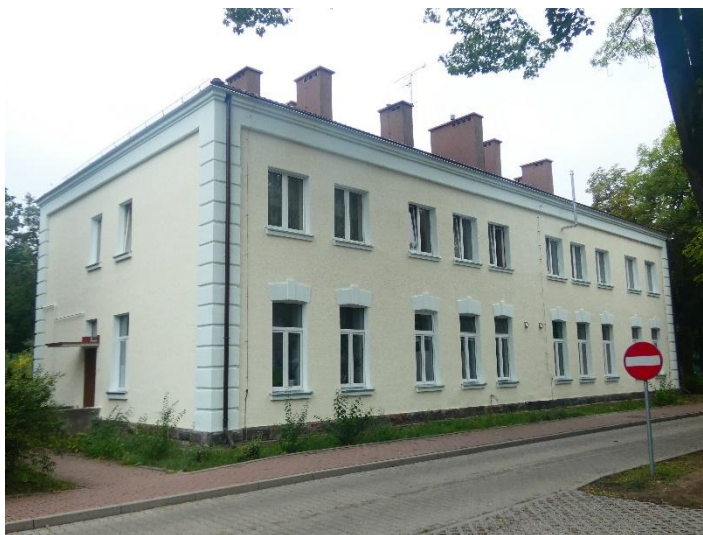
Fot. 4. Zakończone prace remontowe przy budynku na Osiedlu Wojskowym 17 w Białobrzegach
