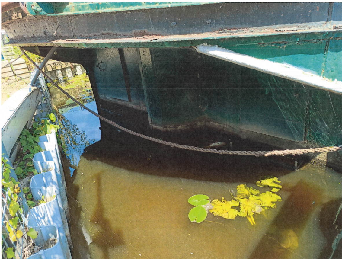
Fot. 33. Część rufowa, widoczna różnica stopnia uszkodzeń spowodowanych korozją części oryginalnej i wtórnej, dospawanej.
