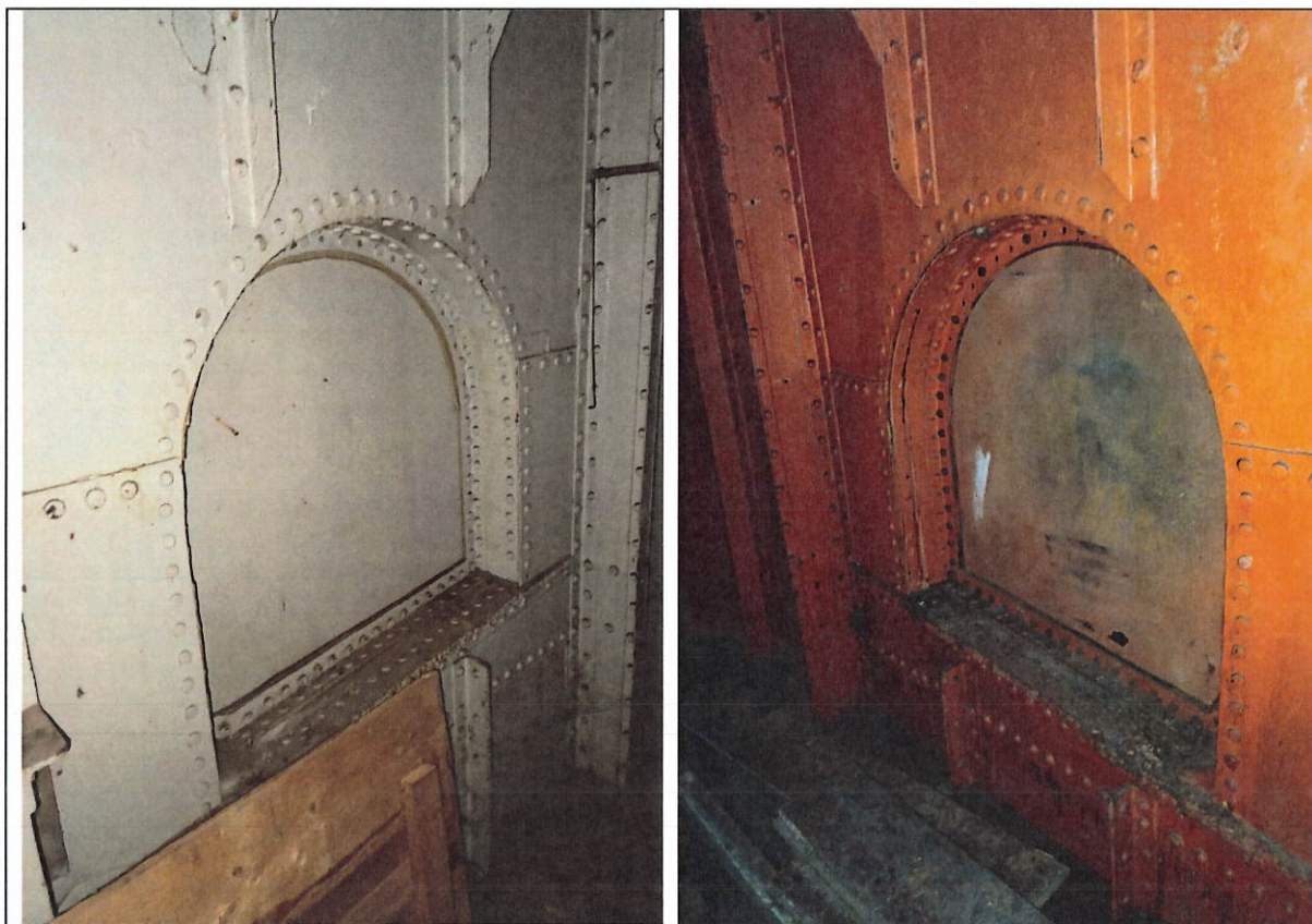
Fot. 43 i 44. Część rufowa podpokładu. Miejsca po usuniętych kołach napędowych.
