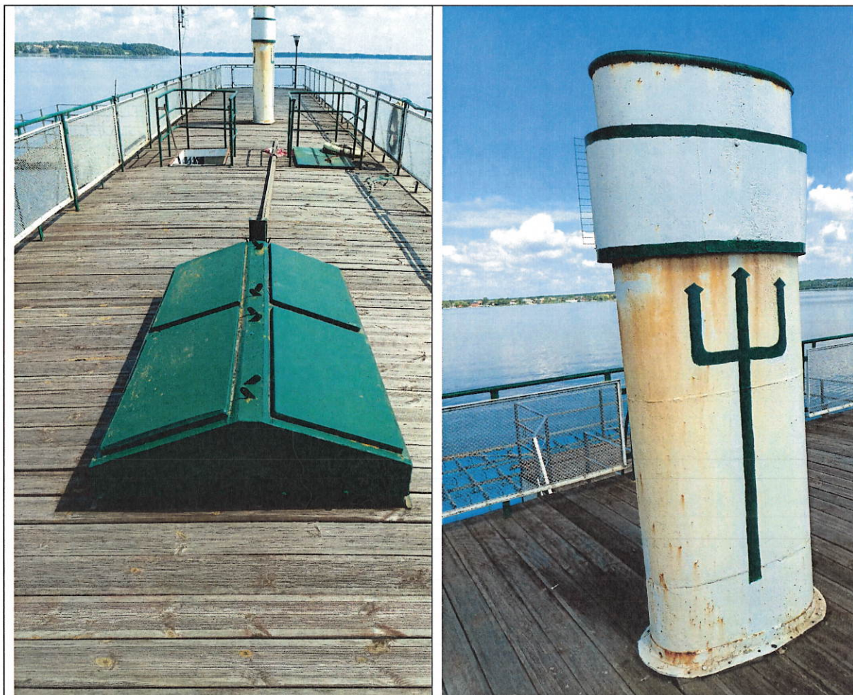
Fot. 17 i 18. Górny pokład, widok zaspawanego zejścia do nadbudówki z lat 60-tych oraz zbliżenie na atrapę komina. Widoczne deski świerkowe w dobrym stanie.
