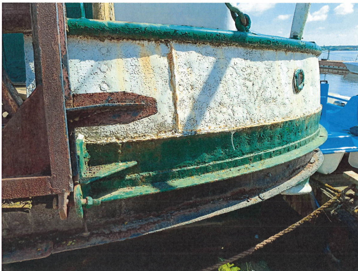
Fot. 30. Rufa, oryginalna nitowana blacha z widocznymi produktami działania korozji.
