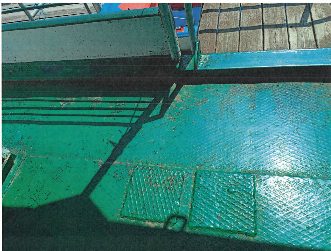
Fot. 22. Zbliżenie na metalowy pokład obejścia nadbudówki.
