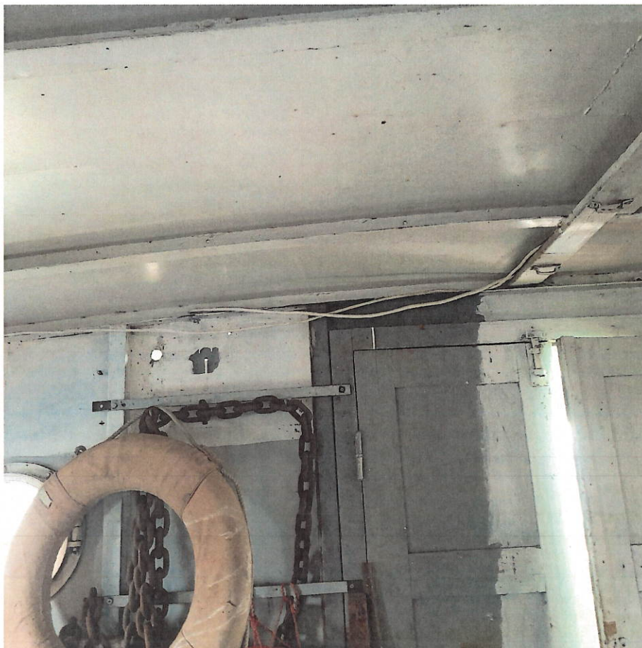
Fot. 70. Ściana rufowa dobudówki z lat 60-tych gdzie ma zostać umiejscowiona izba pamięci, od wewnątrz. Po lewej stronie drzwi widoczny otwór i przewody elektryczne, które mają zostać wykorzystane do zamontowania urządzenia klimatyzacji.
