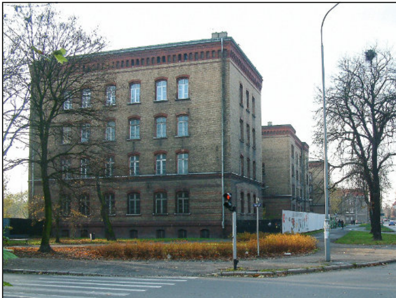
Jeden z budynków koszar przy ulicy Bukowskiej w Poznaniu, w których stacjonował 58. pp (fot. r. Binek, https://pl.wikipedia.org , wgląd 12 lutego 2024 r.)
