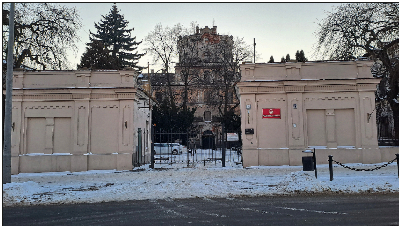
W głębi budynek przy ulicy Bernardyńskiej 13 (pałac Sobieskich, Radziwiłłów, Vetterów) w Lublinie, w którym mieściło się gimnazjum Heleny Czarnieckiej, do którego uczęszczała Anna Boska (fot. M. Pakuła)
