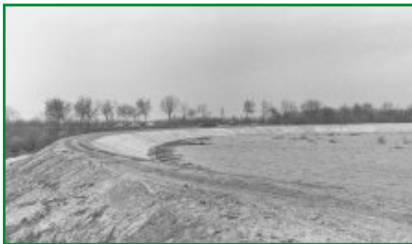
Rys. 5.25. Brzeg Jeziora Żegrzyńskiego w 1963 r. w rejonie Żegrza Południowego, widoczne betonowe płyty chroniące skarpę zapory bocznej (informator CBSiPBW „Hydroprojekt”)
