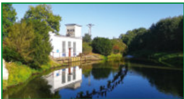
Rys. 5.27. Przepompownia w Ryńi – widok od strony zawała
