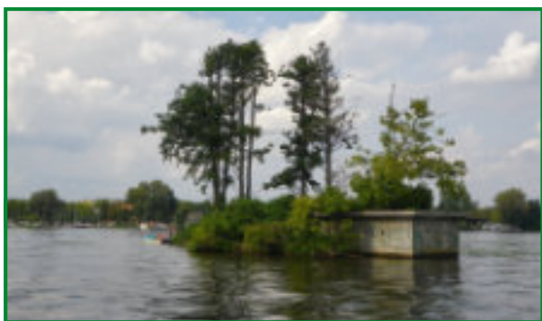
Rys. 5.22. Wyspa Elektryczna k. Zegrza Południowego z widocznym fundamentem dawnego słupa energetycznego
