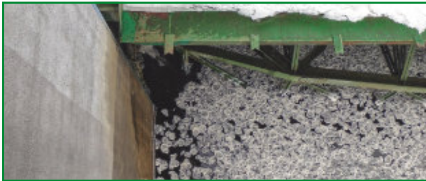
Rys. 5.6. Widok na zasuwę jazu stopnia Dębe z klapą do przepuszczania lodu napływającego ze zbiornika, na dolnym stanowisku widoczny śryż
