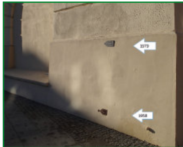
Rys. 3.14. Pułtusk dzwonnica Bazyliki Kolegiackiej i znaki wielkiej wody w latach 1958 i 1979
