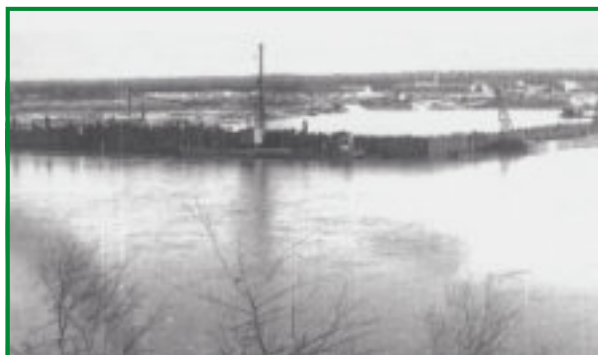
Rys. 5.2. Grodza zmykająca wykop fundamentowy jazu i elektrowni wodnej stopnia Dębe 1958 r. (informator CBSiPBW „Hydroprojekt”)
