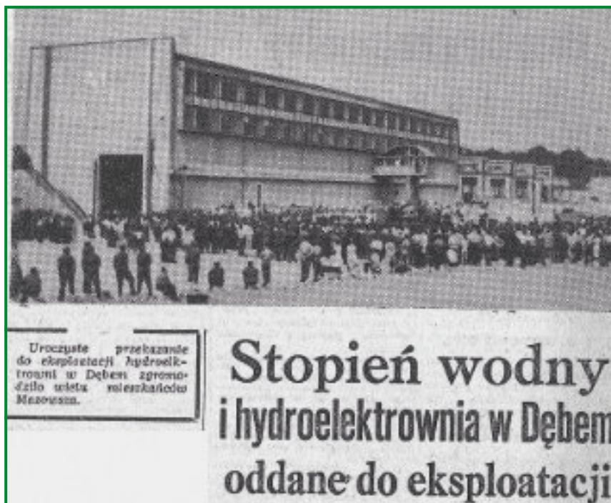
Rys. 5.32. Wycinek z gazety Trybuna Mazowiecka (23 VII 1963) z relacją z otwarcia stopnia wodnego i elektrowni Dębe
