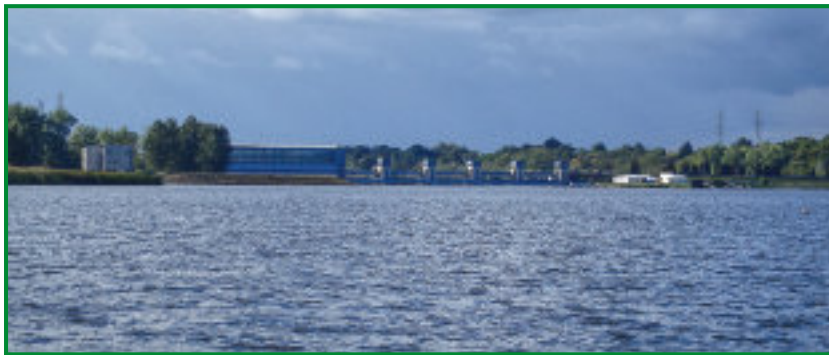
Rys. 5.5. Stopień wodny Dębe od strony wody górnej
