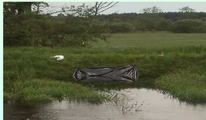
Uszczelnianie wału przeciwpowodziowego na rzece Czarnej.
