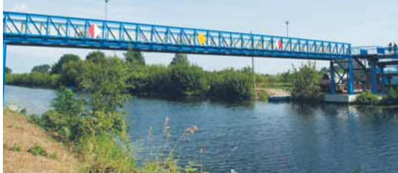
Kładka nad Kanalem Królewskim w Nieporęcie
